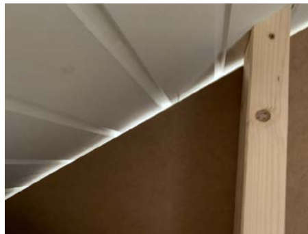
Noe glippe/luftig lettvegg satt opp i boden i loftsetasjen mot trappen.
