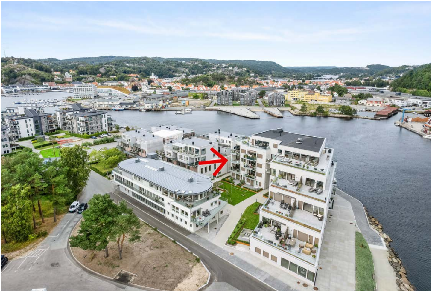
Gjennomgående leilighet med to fine balkonger.
