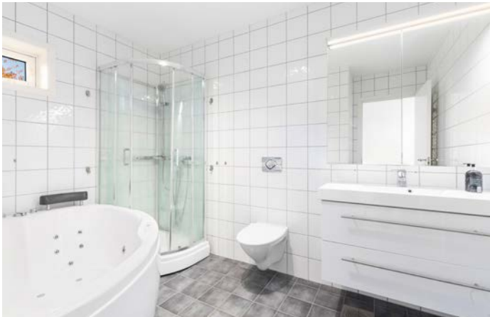
Flislagt bad med varmekabler
