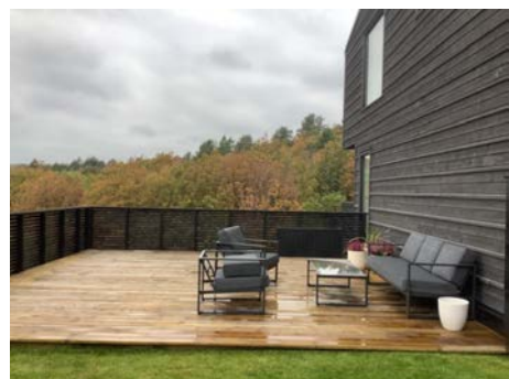
Terrasse ved gavlvegg i 1. etasje.
