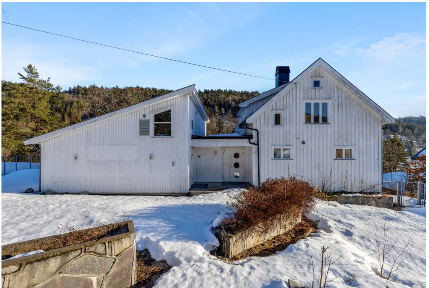
Boligen er innholdsrik og går over to etasjer samt kjeller. Det er behov for renovering/oppussing og boligen bærer preg av at den tidligere har vært en barnehage
