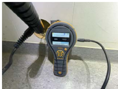
Hulltaking - Fuktmåling - Tørr konstruksjon i hulltakingsområdet.
