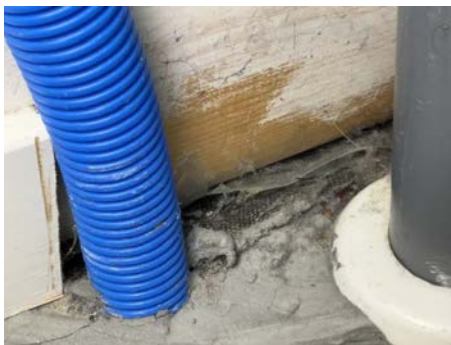
Foto viser manglende membranoppkant langs yttervegger med panel og rundt rørgjennomføring.
