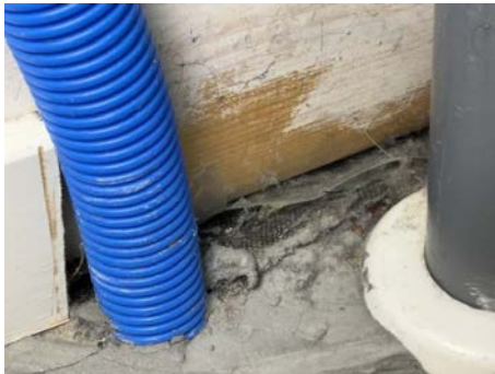
Foto viser manglende membranoppkant langs yttervegger med panel og rundt rørgjennomføring.
