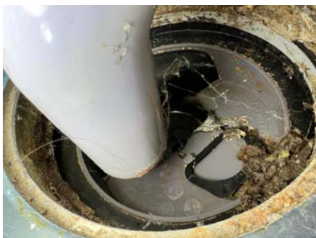
Foto viser manglende membranoppkant langs yttervegger med panel og rundt rørgjennomføring.
