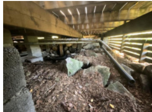
Avløpsrør i plast.
