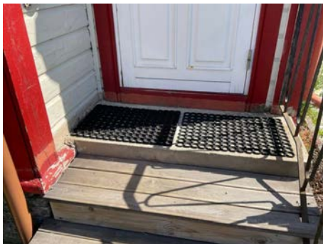
Betongtrapp mot trevegg
