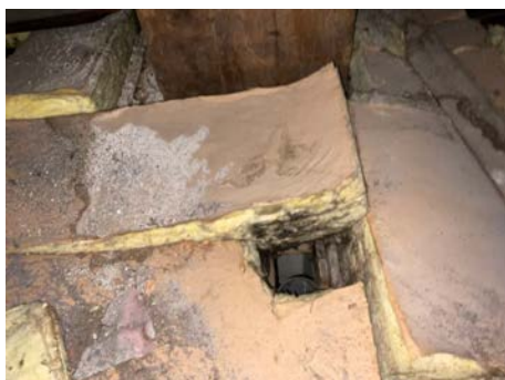
Luftventil må føres over tak.
