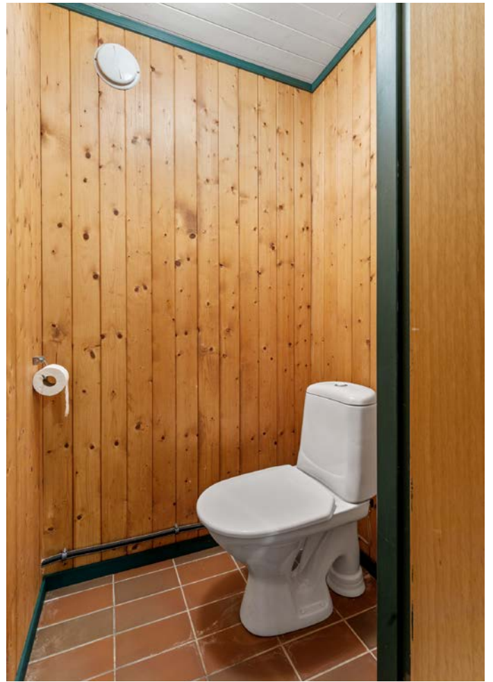
Toalettrom i kjeller
