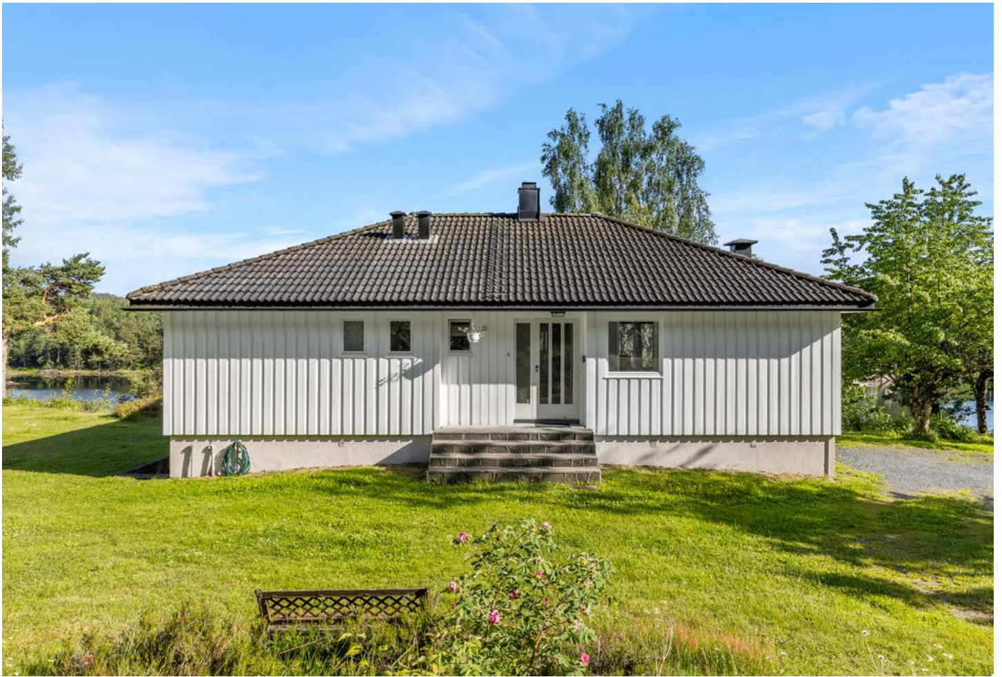
Inngangsparti med trappeadkomst
