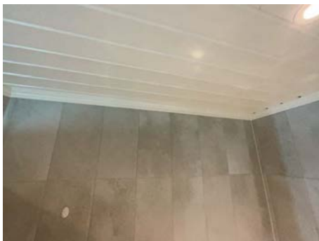
Del av vegg - tak.
