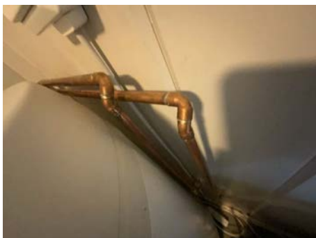
Del av rør til vann.
