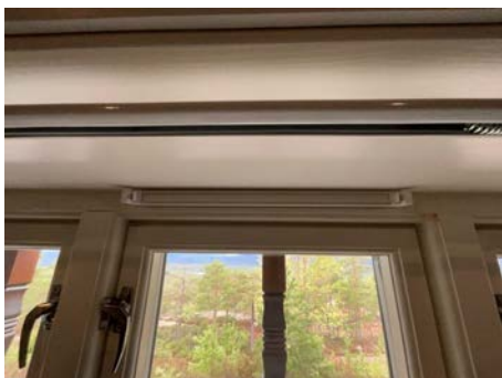
Eksempel på montert ventil i vindu.
