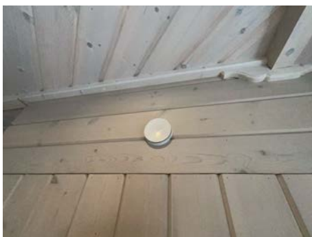
Eksempel på montert ventil i vegg.
