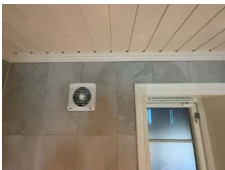
Montert avtrekk i vegg.
