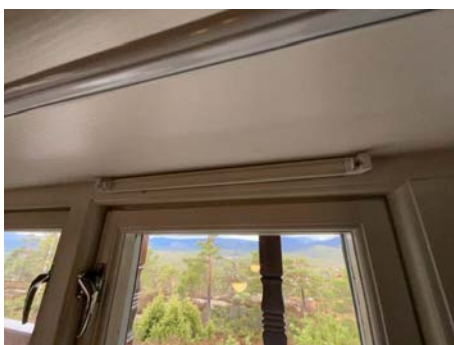
Eksempel på montert ventil i vindu.
