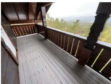
Del av terrasse i 2 etasje.
