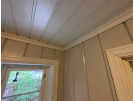
Del av vegg - tak.
