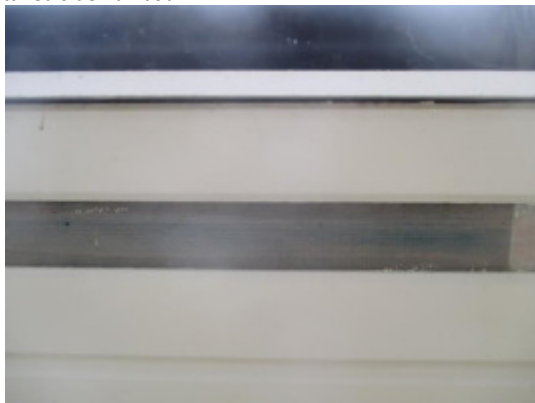
Bra med lufting i gesimser. (noen hull i fluenetting ble registrert)
