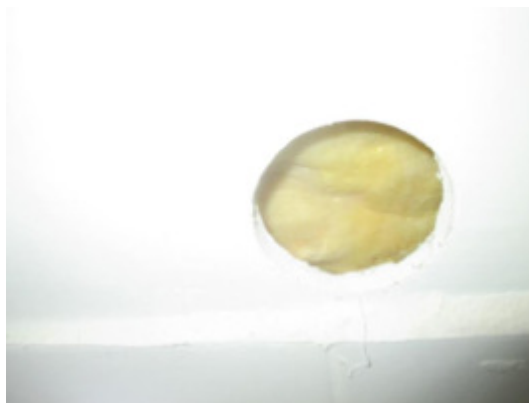
Hulltaking i fra vaskerommet.
