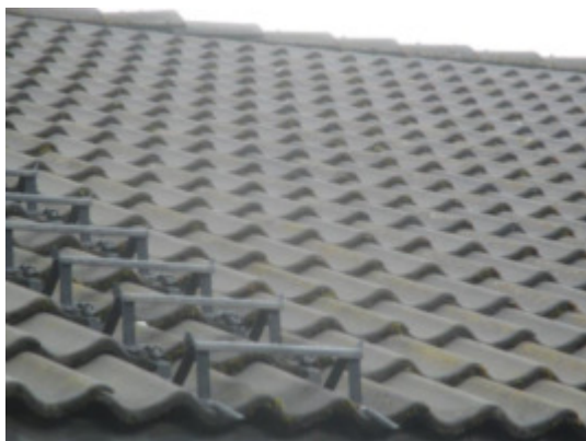
Deler av taktekkingen.
