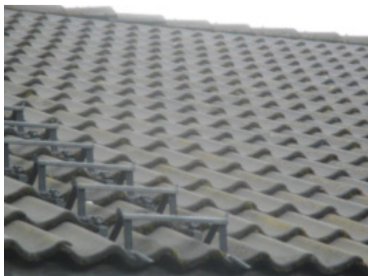
Deler av taktekkingen.
