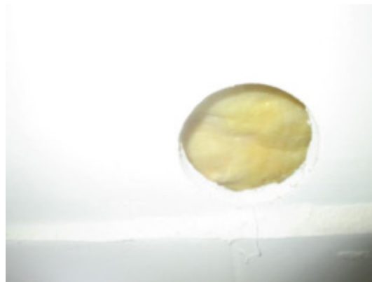
Hulltaking i vegg i mot bad.
