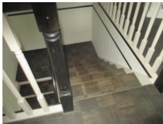
Trapp med åpne opptrinn til loftet.
