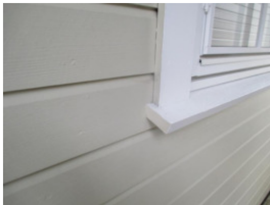
Deler av kledningen med belistninger.
