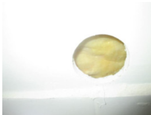
Hulltaking i fra vaskerommet.
