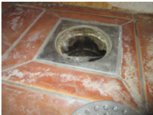
Sluk under innredningen.
