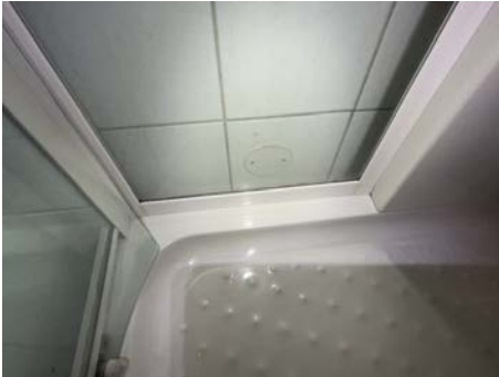
Blindlokk bak dusjkabinett i våtsone
