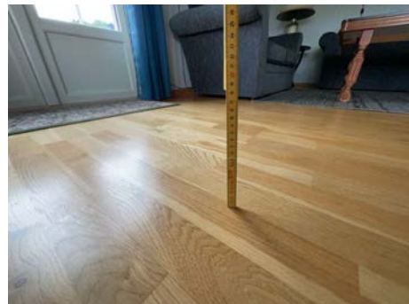
Utkastrek på laser er 11 cm på målestokk. Bilde viser ca. 17 mm høydeforskjell gjennom rommet i stue
