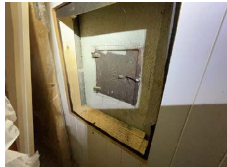
Sot-/feieluke for nært brennbar materiale i kjeller
