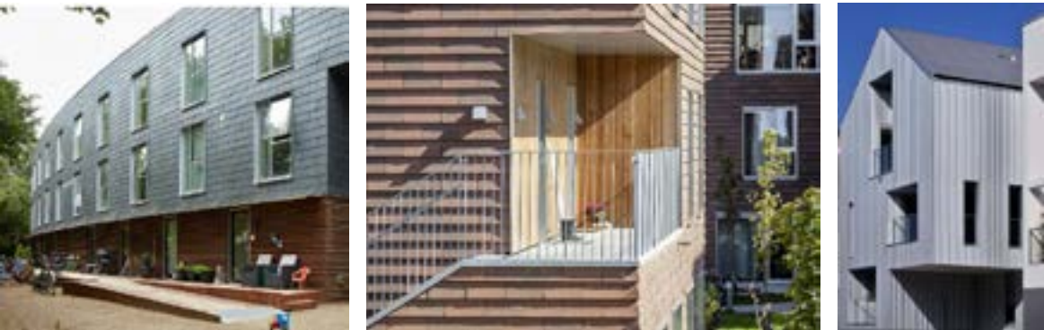
Eksempler på kledninger for leilighetsbyggene BBB1-BBB3. Tv. Skiferkledning m. bekledningstegl th. korrugerte aluminiumsplater
