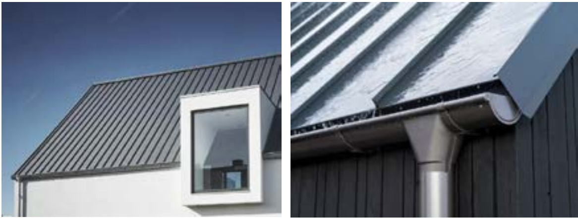
Eksempel på plannja trend 475, PL 15 mørk sølv metallic tak og detaljering rundt nedløpsrør.
