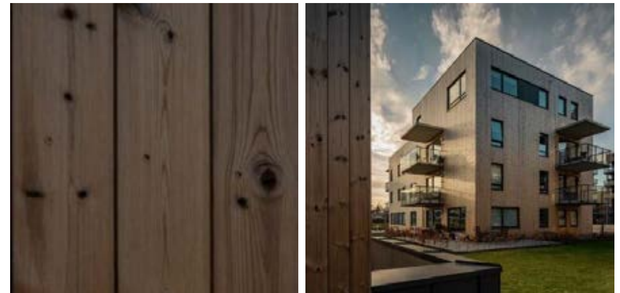
Eksempel på kledning i upigmentert varmebehandlet furu.
