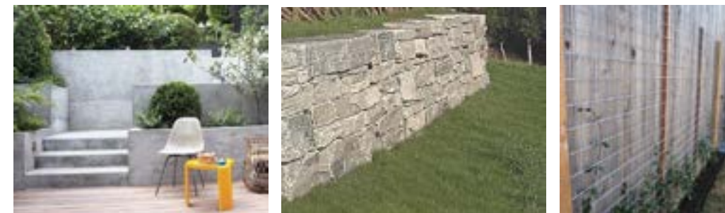
Eksempler på støttemur: Tv. terrassert støttemur i betong. Midt stable stein i lokal stein. Th. espalier langs vegg
