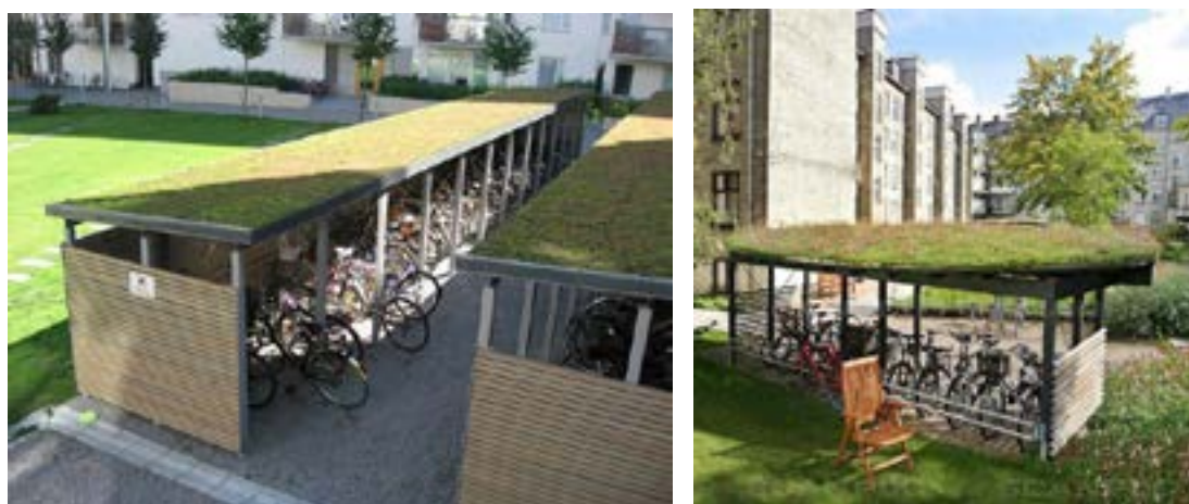
Eksempler på overdekket sykkelparkering, med grønne sedumtak
