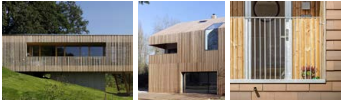
Eksempel på tre spiler rekkverk tv. Eksempel integrerte rekkverk i tett fasade midt. Eksempel på diskret rekkverk i galvanisert stål th.
