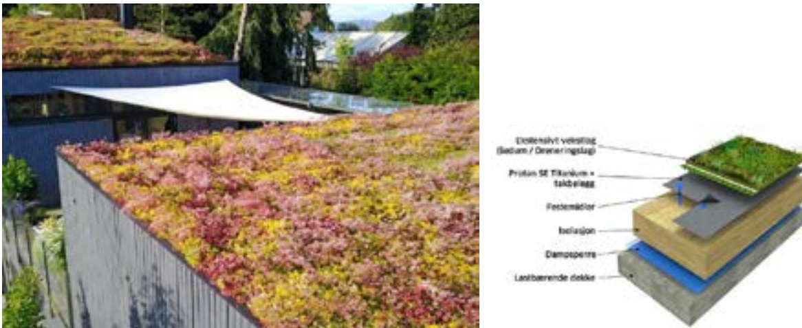
Eksempel på sedumtak tv. mulig oppbygging av sedumtak th.
