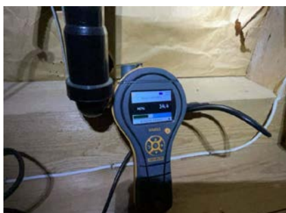
Fuktmåling - Tørr konstruksjon i det kontrollerte området.
