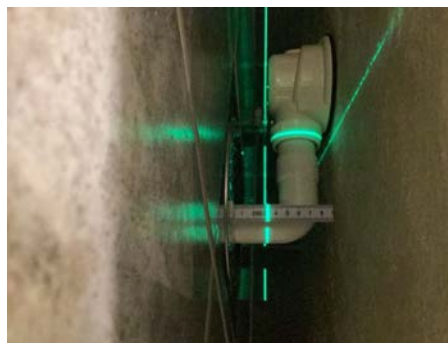
Måling ved sluk
