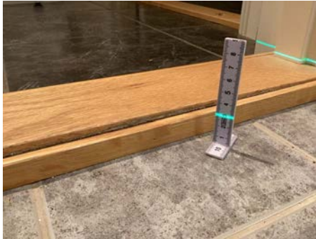
Måling ved terskel
