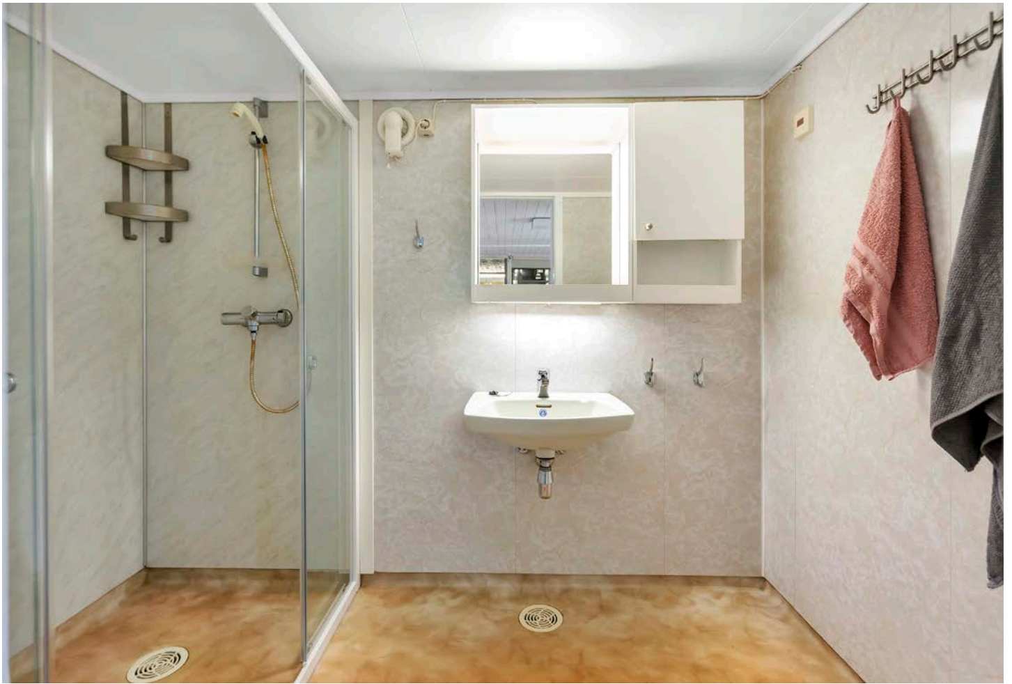
Bad i kjeller
