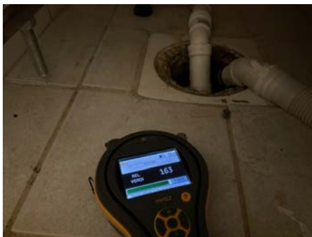
Begrenset tilgang til sluk under badekar. Deksel ble demontert
