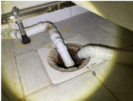
Begrenset tilgang til sluk under badekar. Deksel ble demontert
