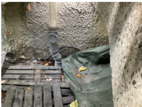
Taknedløp på inngangside ledes til overvannsrør
