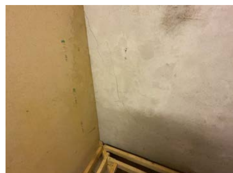
Bilde viser eks. på innvendig skråriss
