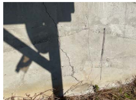
Bilde viser eks. på utvendig skråriss
