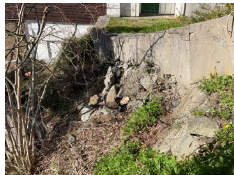
Bilde viser delvis løsnet fylling under forstøtningsmur og manglende rekkverk.
