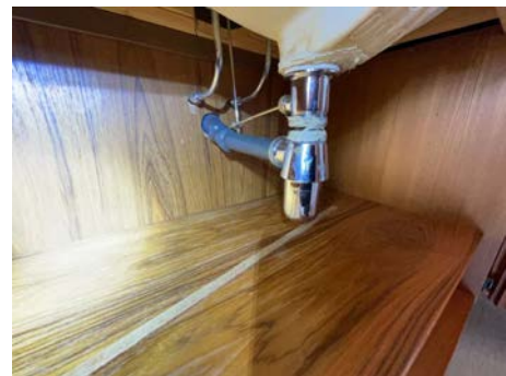
Bilde viser eks. på fuging av avløpsrør
