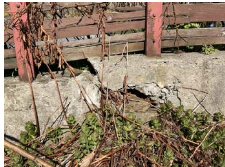
Bilde viser delvis løsnet fylling under forstøtningsmur og manglende rekkverk.
