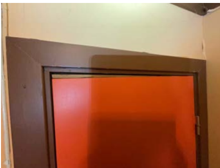
Bilde viser eks. på skjevt dørbblad
