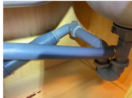
Bilde viser eks. på fuging av avløpsrør
