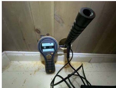
Hulltaking - Fuktmåling - Tørr konstruksjon i hulltakingsområdet.
