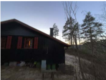
Vifte med lufting til over tak.
