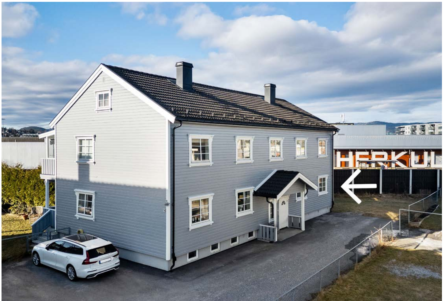
Beliggende i byggets første etasje, har boligen en enkel adkomst med kun få trappetrinn fra felles oppgang.
