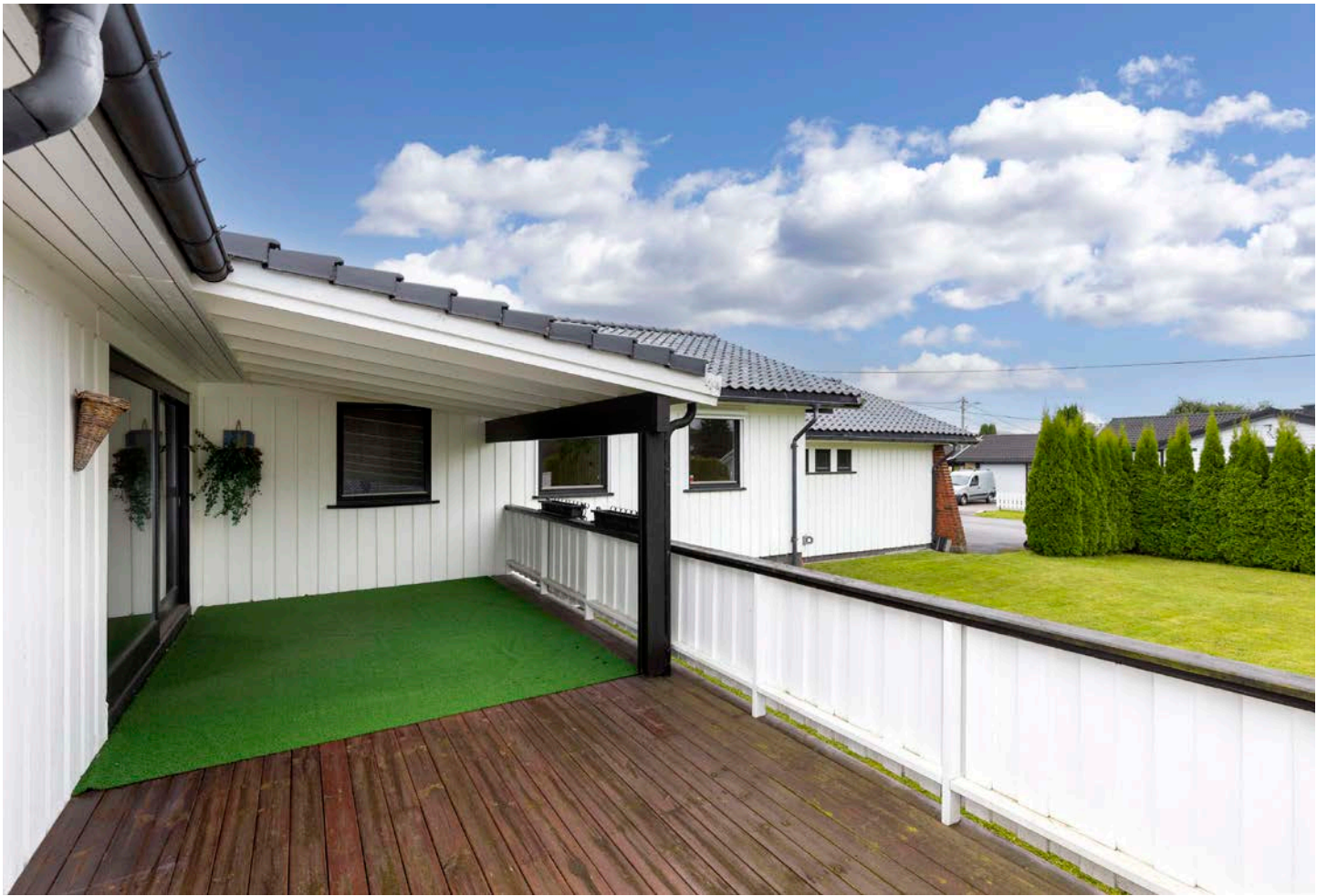
Delvis overbygget veranda
