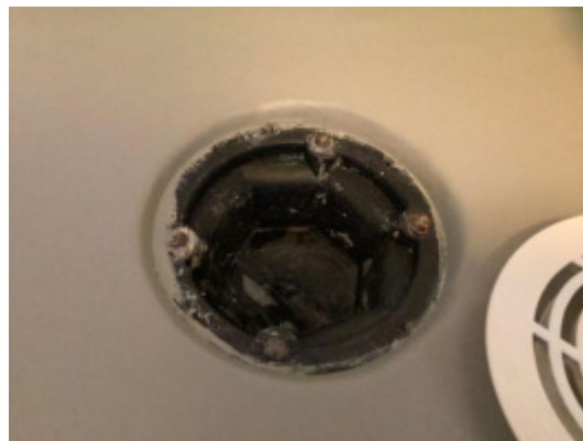
Eldre sluk med vinylbelegg
