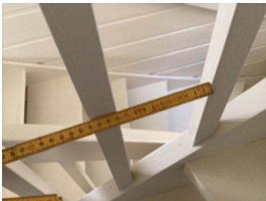
Åpninger i rekkverk er større enn dagens krav på 10cm
