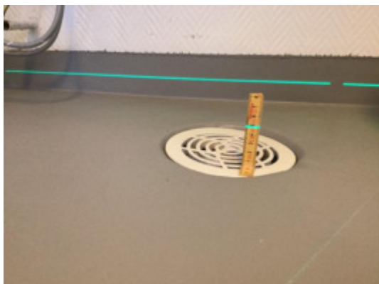
Måling ved sluk
