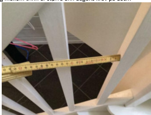
Åpninger i rekkverk er større enn dagens krav på 10cm
