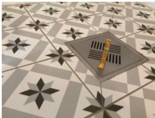
Måling ved sluk
