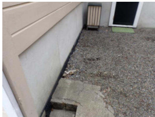
Synlig grunnmursplast bak bolig
