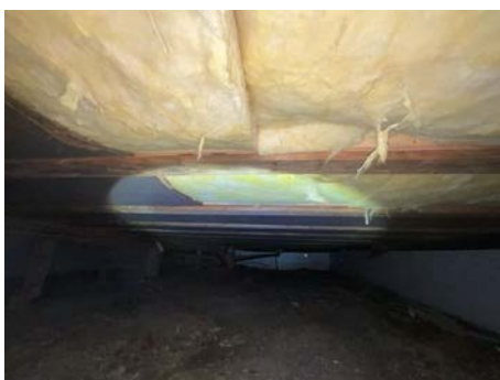
Del av etasjeskille sett fra undersiden.
