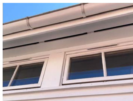
Eksempel på montert ventil i vindu.
