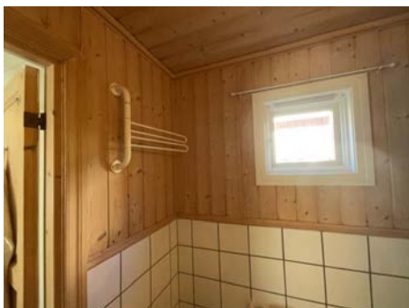
Del av vegg - tak.
