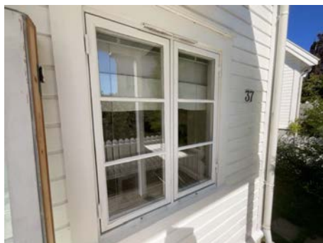
Eksempel på vindu i yttervegg.
