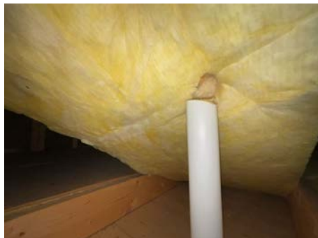
Lufting som stopper på loft.
