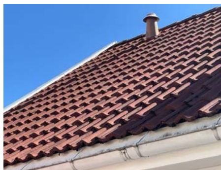
Del av taktekking.
