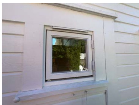
Eksempel på vindu i yttervegg.
