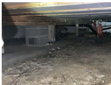
Feieluke i krypkjeller.
