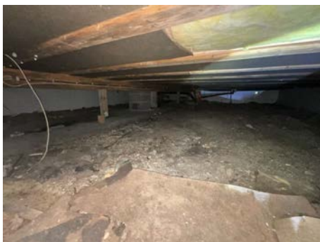
Del av krypkjeller.
