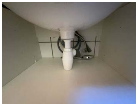
Del av rør til vann.
