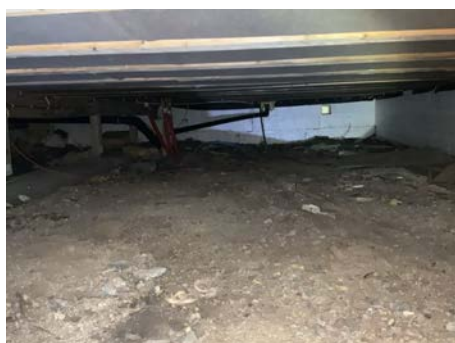
Del av rør til avløp.
