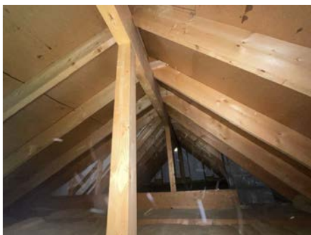
Del av takkonstruksjon, sett fra loft.
