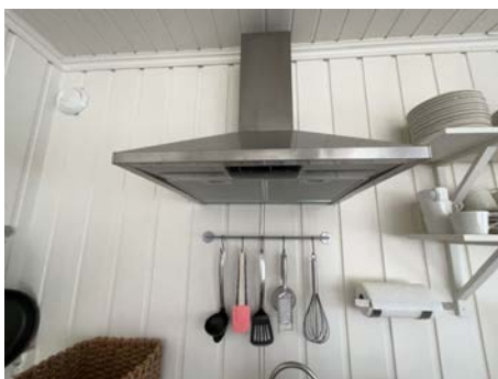
Montert avtrekk over steketopp.
