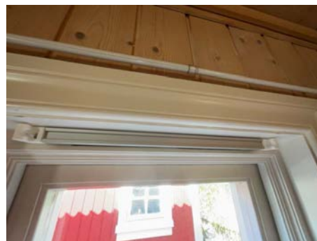
Eksempel på montert ventil i vindu.
