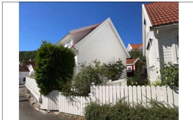
Hytte oppført på eiendommen.
