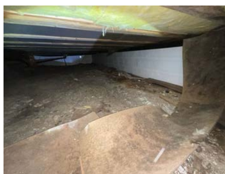
Del av krypkjeller.
