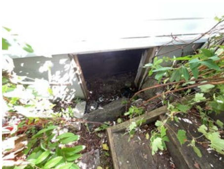
Luke inn til krypkjeller.
