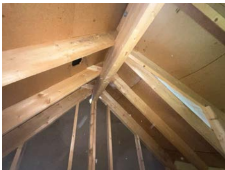
Del av takkonstruksjon, sett fra loft.
