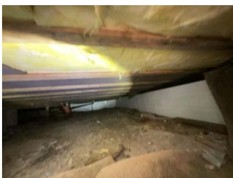
Del av etasjeskille sett fra undersiden.
