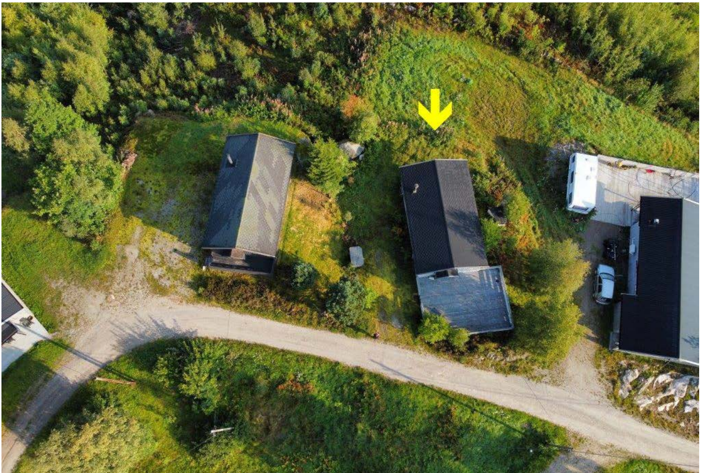
Oversikt tomt og bygning
