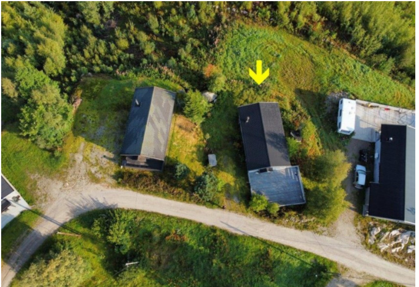
Oversikt tomt og bygning
