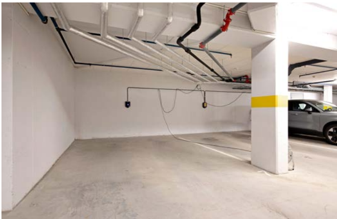
Garasje plass og bod i parkeringskjeller.
