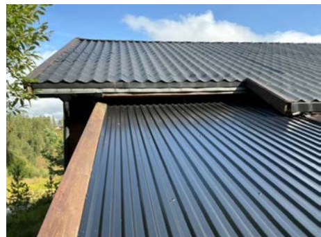
Mangler beslag overgang takrenne.
