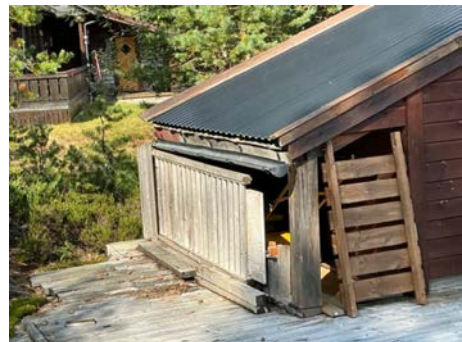
Mangler beslag overgang takrenne.
