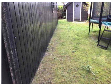
Kledning / veggfot mot terreng.
