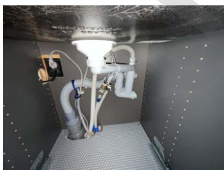
Del av rør til avløp.
