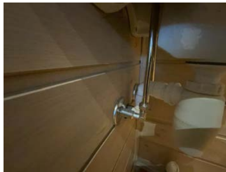
Del av rør til vann.
