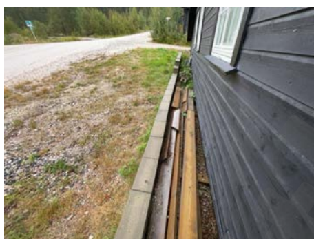
Del av forstøtningsmur.
