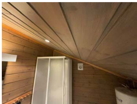
Del av vegg - tak.
