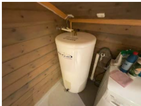
Varmtvannstank.
