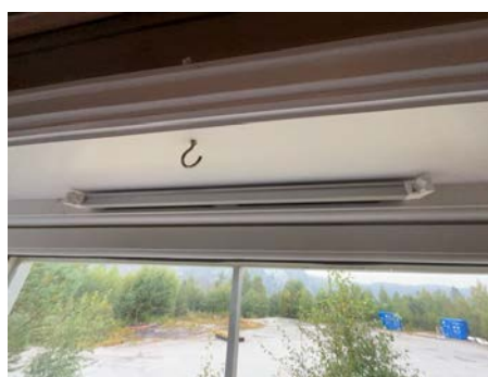
Eksempel på montert ventil i vindu.
