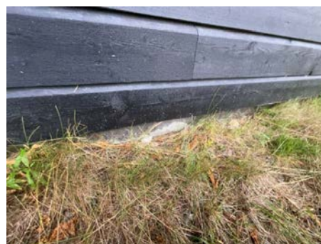
Del av grunnmur.
