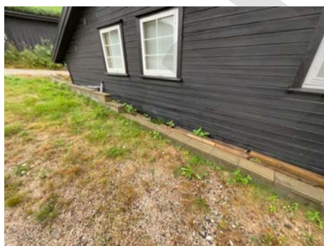
Del av forstøtningsmur.
