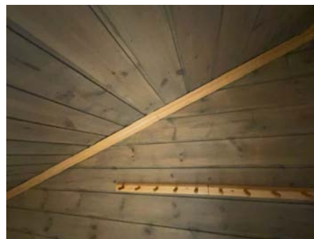
Del av vegg - tak.
