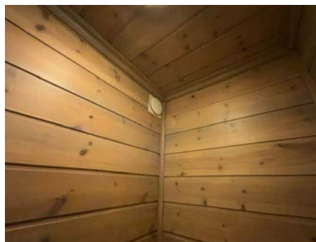
Del av vegg - tak.
