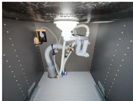
Del av rør til vann.
