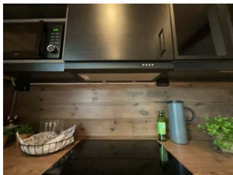
Montert avtrekk over steketopp.
