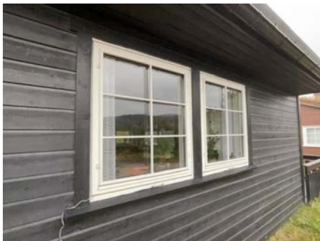
Eksempel på vindu i yttervegg.
