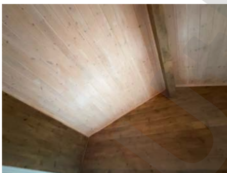
Del av vegg - tak.
