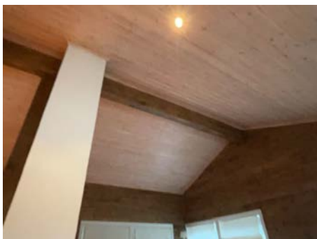
Tak sett fra innsiden.
