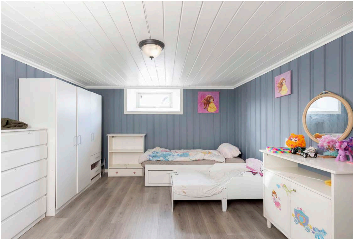
Kjellerrom som blir benyttet som soverom. Ikke godkjent som soverom.
