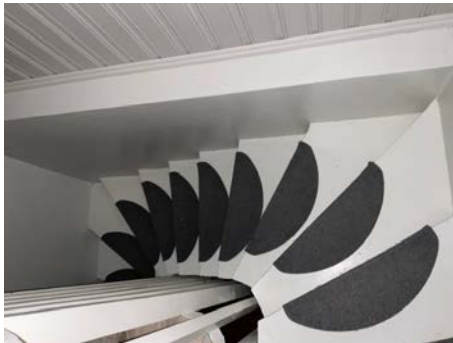
Betongtrapp til kjeller.
