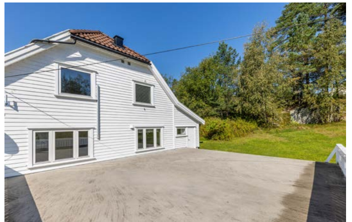
Takterrasse over garasjen - betong.
