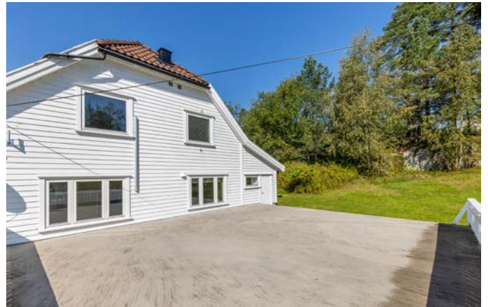
Takterrasse over garasjen - betong.
