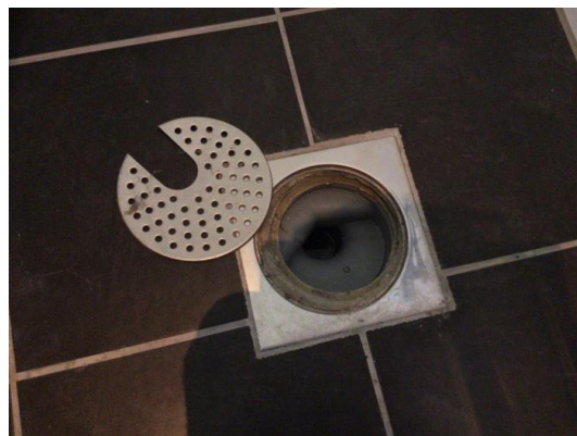
Sluk i gulv.
