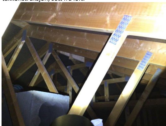
Del av takkonstruksjon, sett fra loft.
