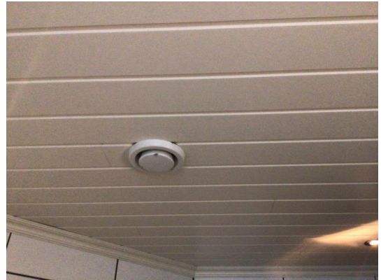
Montert avtrekk i tak.
