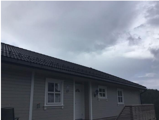
Del av taktekking.
