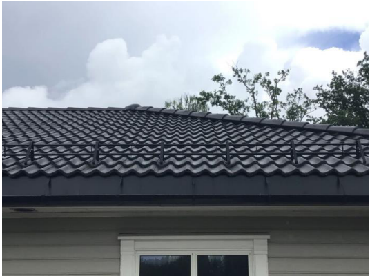
Del av taktekking.
