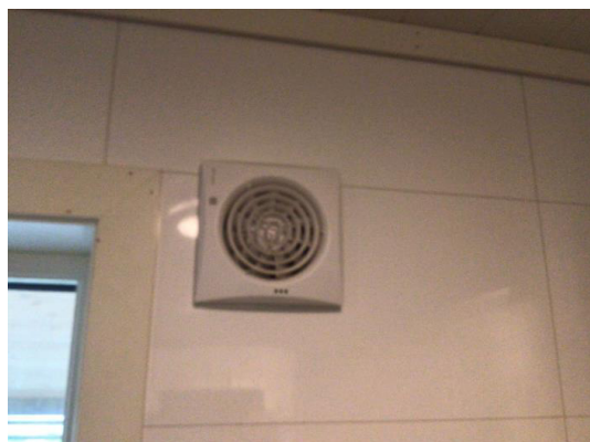
Montert avtrekk i vegg.
