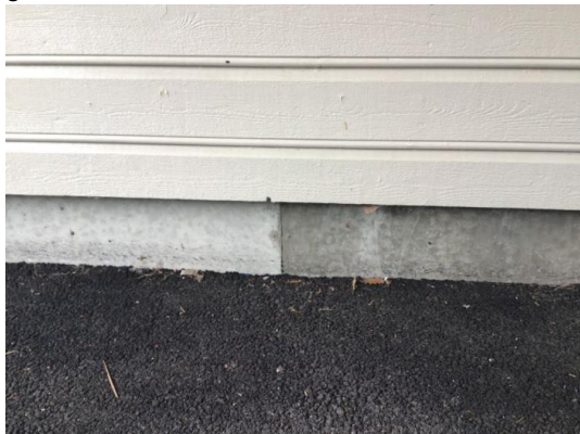
Del av grunnmur.
