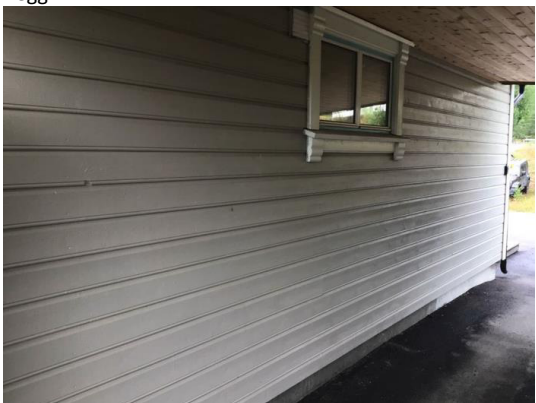
Del av vegg.
