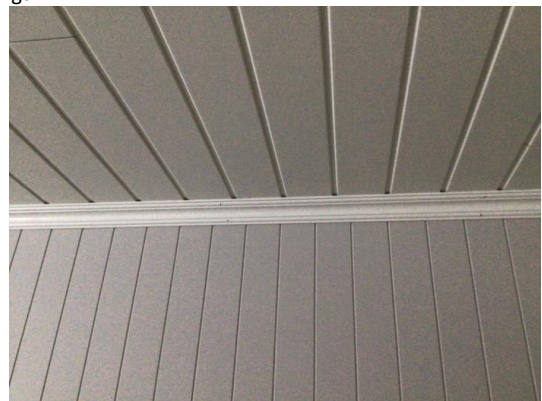
Del av vegg - tak.
