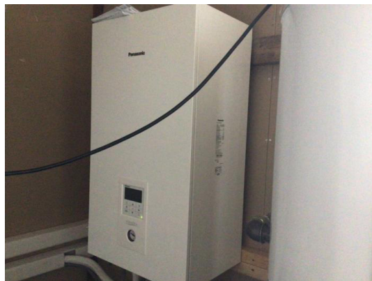
Innerdel til vannbåren varme.
