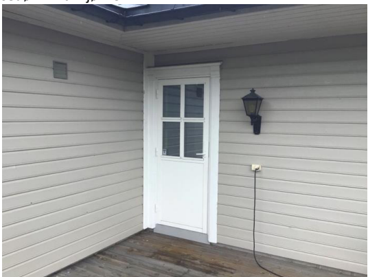
Terrassedør inn til vaskerom.
