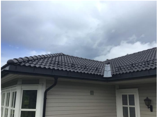
Del av taktekking.
