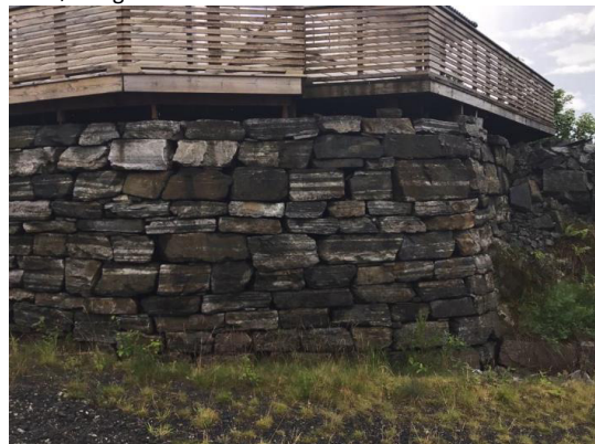
Del av forstøtningsmur.
