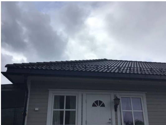
Del av taktekking.
