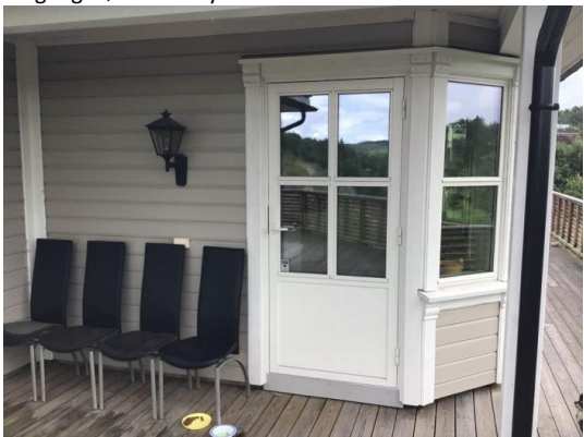
Terrassedør inn til kjøkken.
