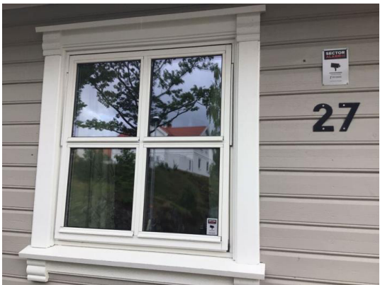
Eksempel på vindu i yttervegg.
