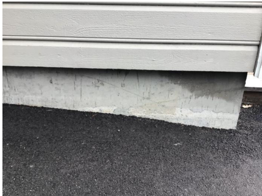
Del av grunnmur.
