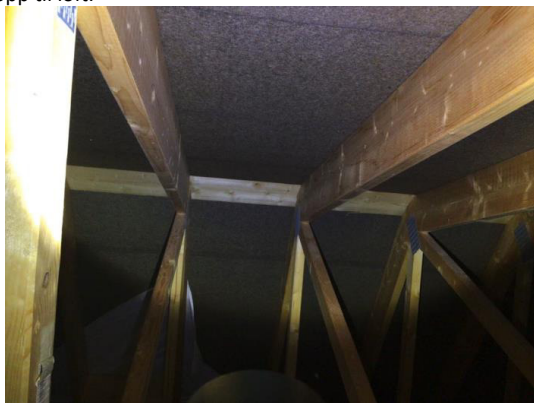
Del av takkonstruksjon, sett fra loft.
