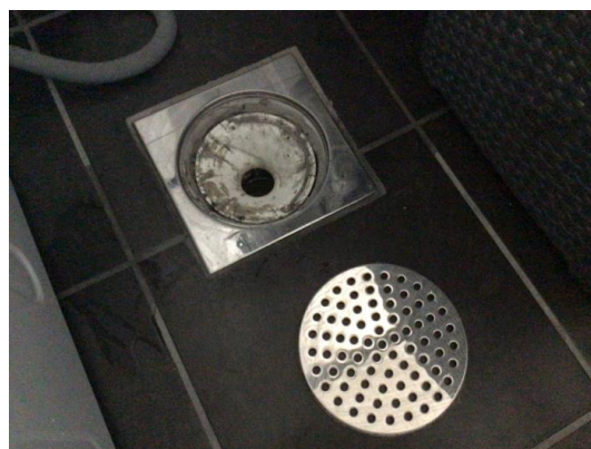
Sluk i gulv.
