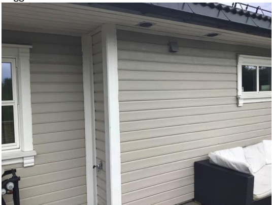
Del av vegg.
