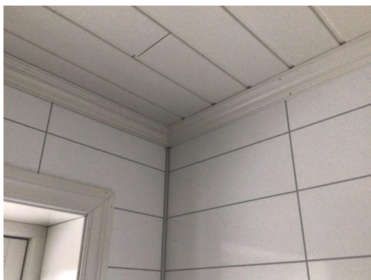
Del av vegg - tak.
