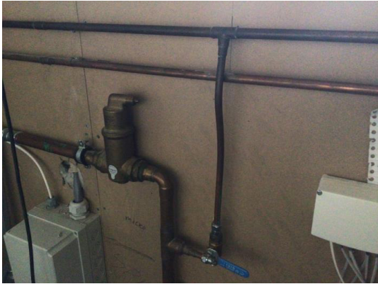
Del av rør til vann.
