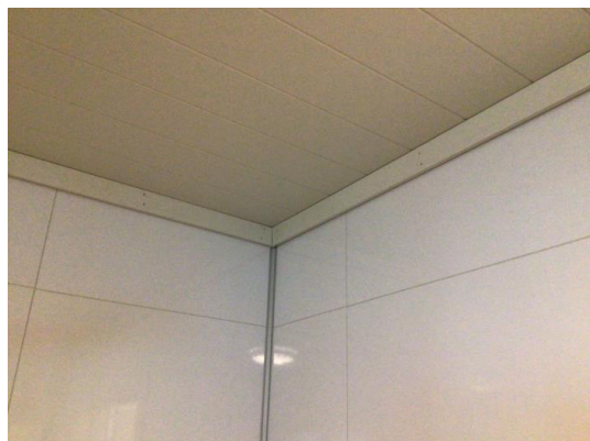
Del av vegg - tak.
