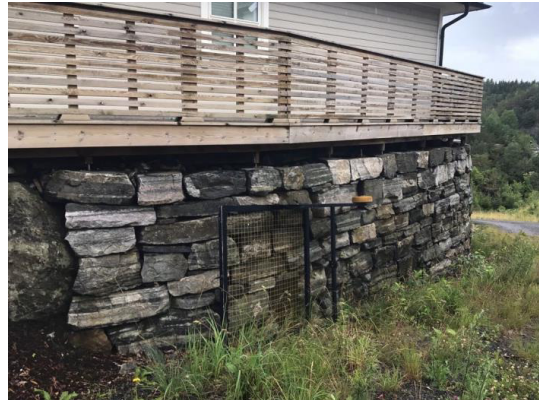
Del av forstøtningsmur.
