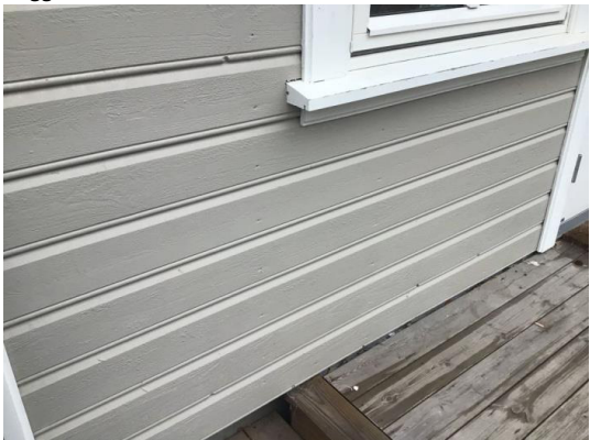
Del av vegg.
