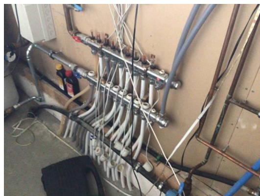
Eksempel på rør til vannbårenvarme.
