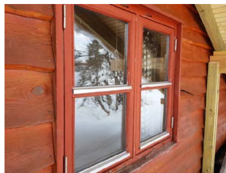
Vindu fra byggeår.
