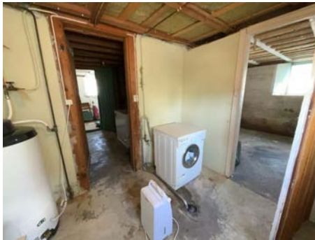
KJELLER / UNDERETASJE > VASKEROM
