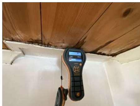
Misfarget og oppfuktet innvendig takpanel ved pipegjennomføringen.
