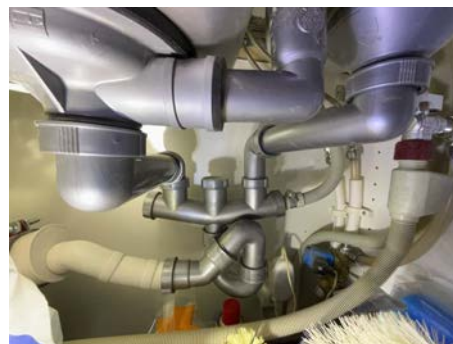
Synlige avløpsrør av plast fremstod i god stand og fagmessig montert.
