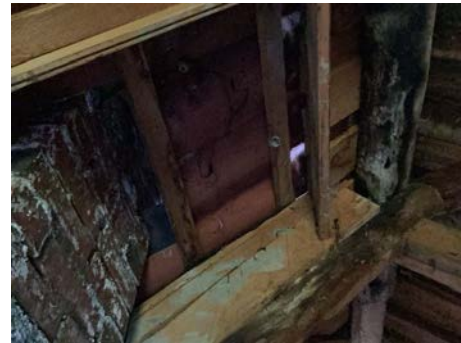
Uttett undertak. Det er klippe under stein og inn
