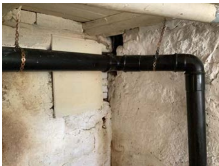
Avløpsrør i plast
