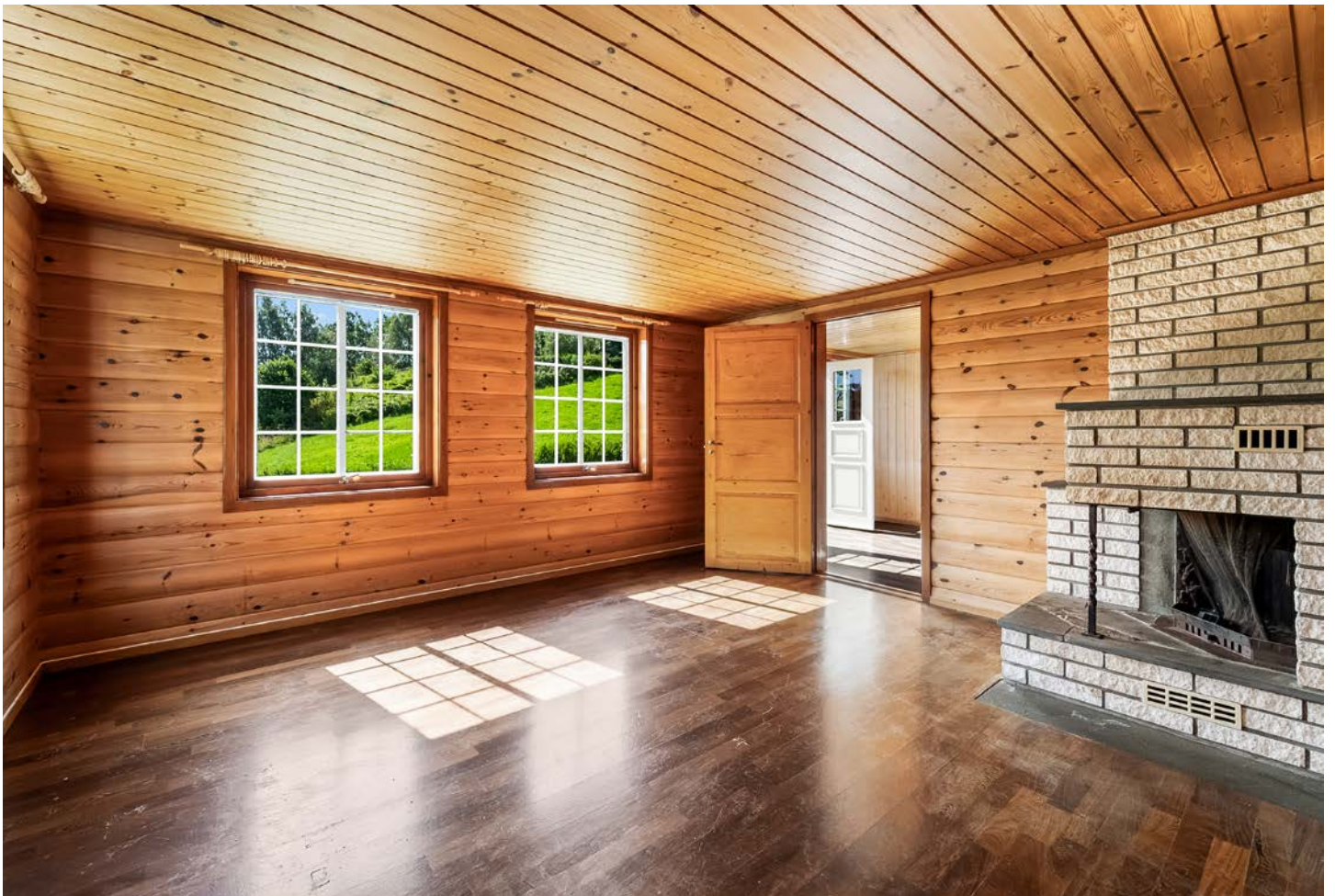
Pipeløp i østre del er en eldre teglsteinspipe som bør fores, ref. tilstandsrapport.
