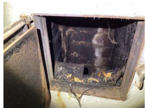
Element pipe med øverste del i tegl
