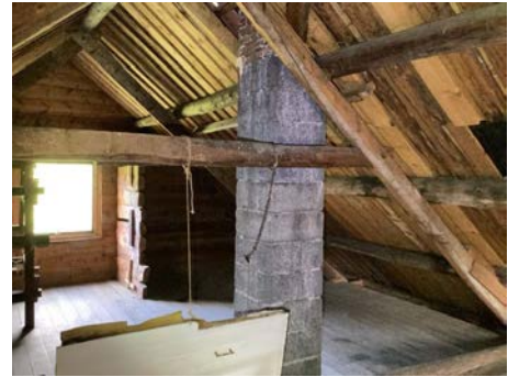
Element pipe med øverste del i tegl
