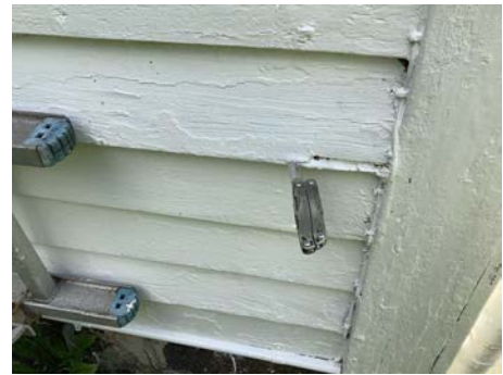
Spredt råteskader
