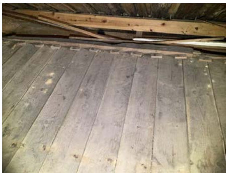
Spor etter stripet borebiller i konstruksjon
