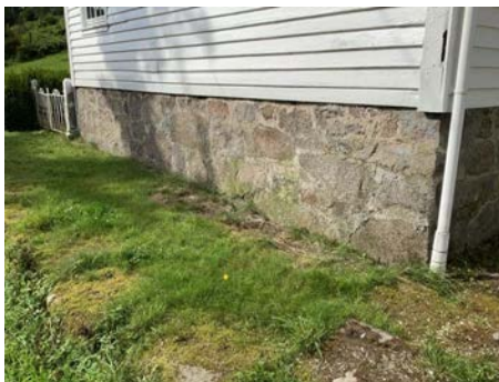
Eldre mur fra byggeår
