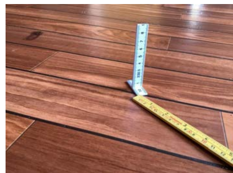
Måling i stue 1 etg på 2 meter
