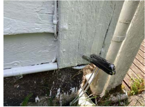
Spredt råteskader
