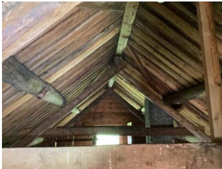
Oversikt over konstruksjon
