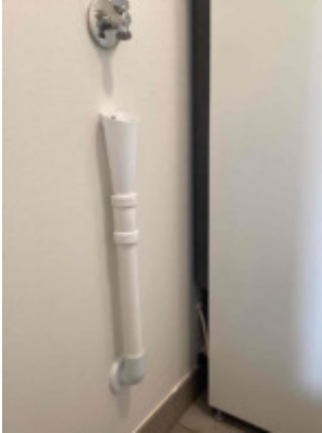
Vanntilførsel og overløp for vaskemaskin.
