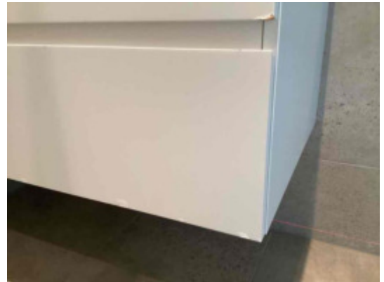
Knatt og fuktmerker på fronter.
