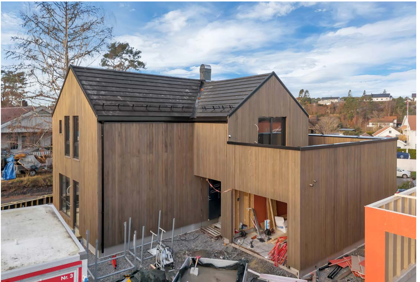
Byggeplass bilde av den aktuelle boligen, tatt november 2024
