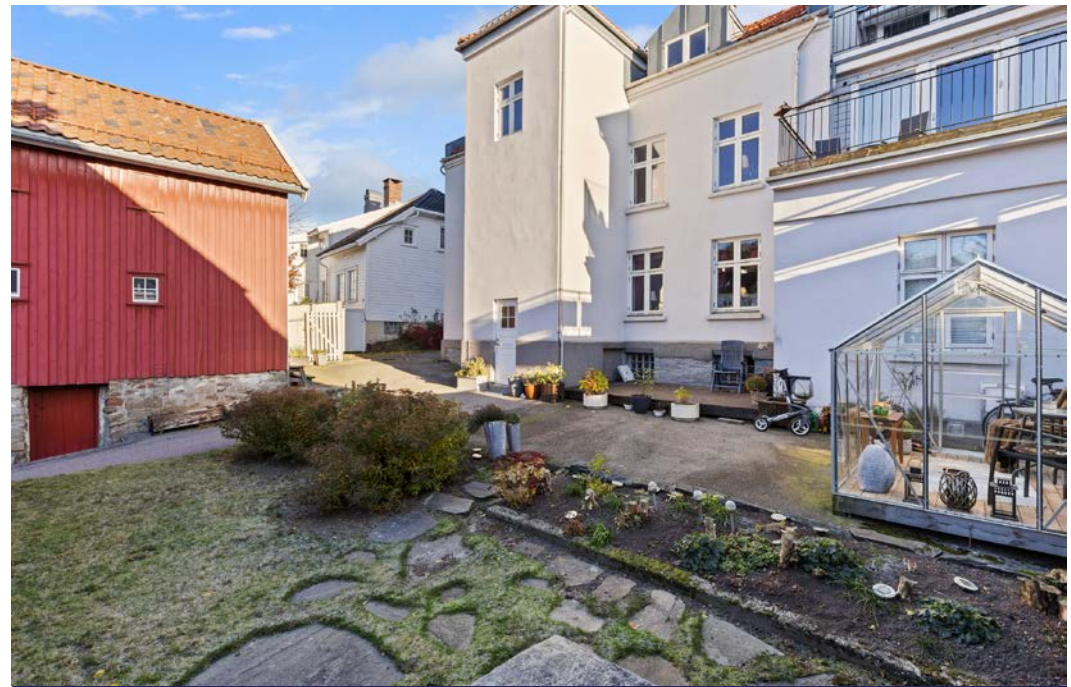
Bygget er oppført i mur med totalt 6 leiligheter som alle er utleid samt kjeller.
