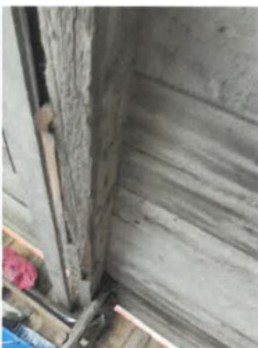
Innsiden av bod
