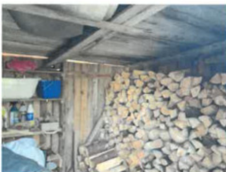
Innsiden av bod
