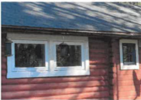
Vinduer i stue og kjøkken
