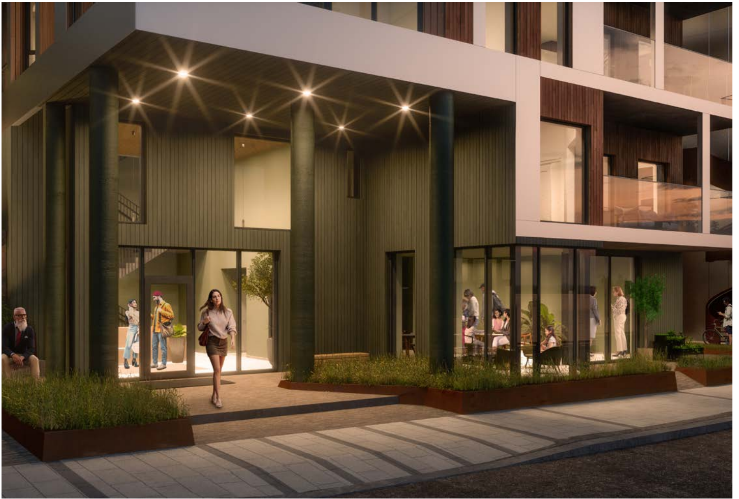
Hovedinngang og fellestue beliggende i 1.etg. i søster 2. Heis til 3. etg., gangbane bort til hus 3. Heis fra 3.-15.etg.
