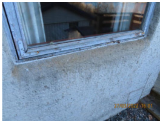
Råteskadet vinduskarm
