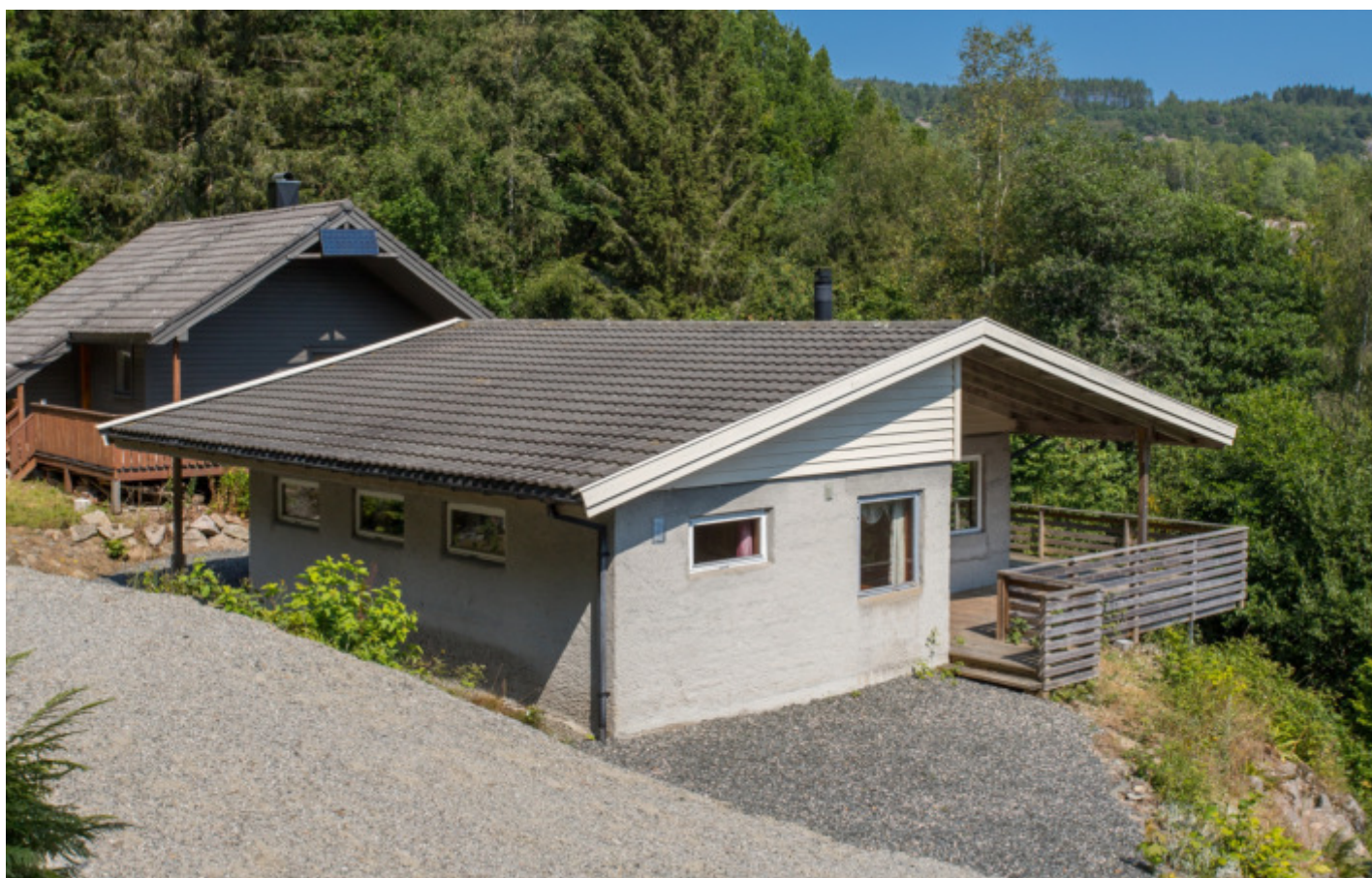
Gruset sti/vei og pukk rundt hytten. Stor veranda.
