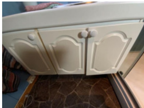
Litt løse og skjeve dører.
