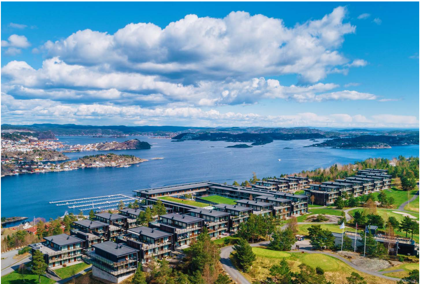
Kragerø Resort like ved eiendommen
